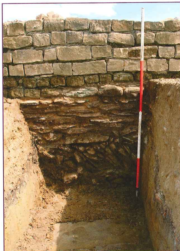
FONDACTIONS DU MUR OUEST DE LA PETITE COUR, VUE VERS L'EST.
